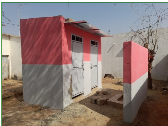
Poste de santé de Bambey Sérère
