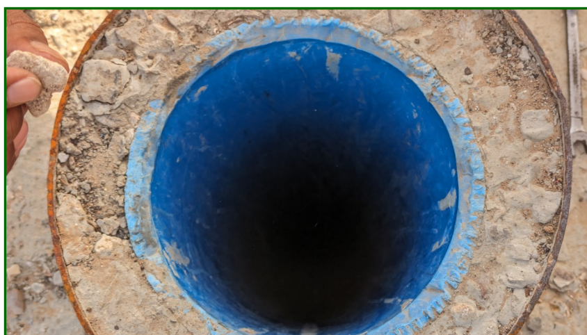
Inspection des travaux de forage
